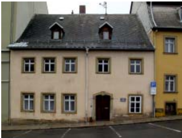
Die Vorderansicht des ›Alten Kantorats‹ (gegenwärtiger Zustand) sowie das Gebäude im Ensemble des Ernstthaler Neumarktes.
